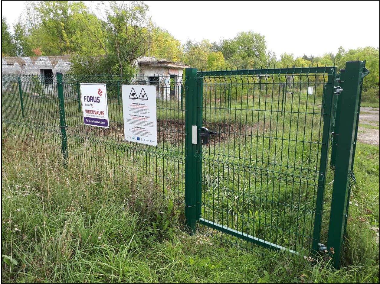
Foto 1. Rohelistest keevispaneelidest piirdeaed koos lukustatava värava ja teabesiltidega Vääna (Humala) projektialal asuva püstsahti ümber Kaitseliidule kuuluval maaüksusel. Foto: Lauri Klein
