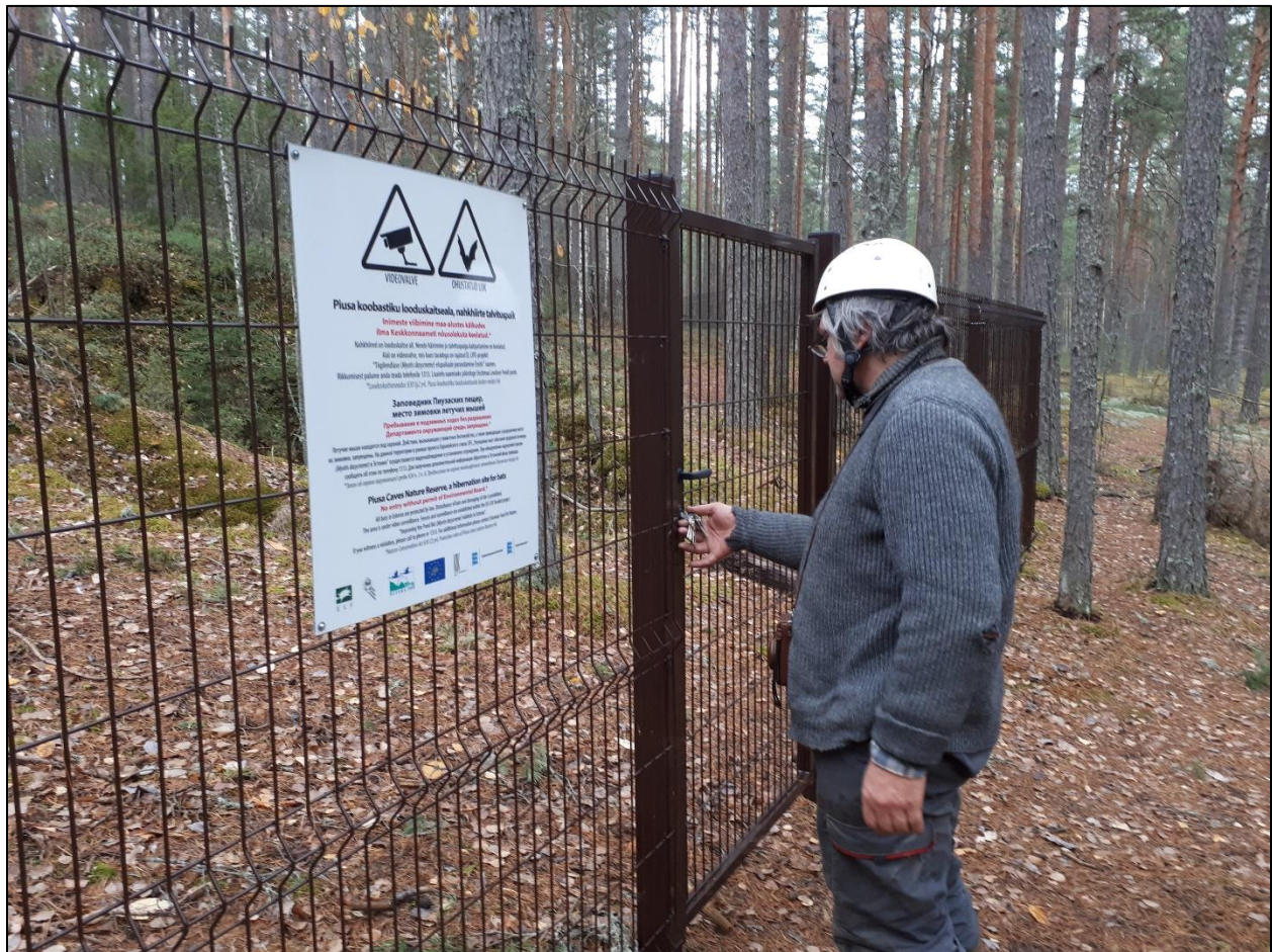
Foto 4. Pruunidest keevispaneelidest piirdeaed koos lukustatava värava ja teabesiltidega Piusa projektialal asuva sissepääsu ümber. Foto: Lauri Klein
